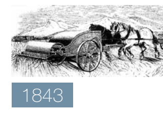
RIDLEY'S STRIPPER Von Pferden ins Feld geschleppte Maschine zum Abstreifen und Einsammeln der Ähren. Mit starkem Bezug zum antiken Vorbild.
