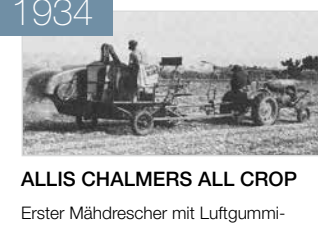
ALLIS CHALMERS ALL CROP Erster Mähdrescher mit Luftumwälzung. Fand rasch Nachahmer.
